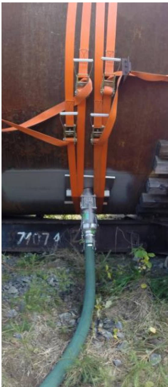
Kuva 5. Reikä on tehty onnistuneesti ja säiliön tyhjennys on käynnissä.
