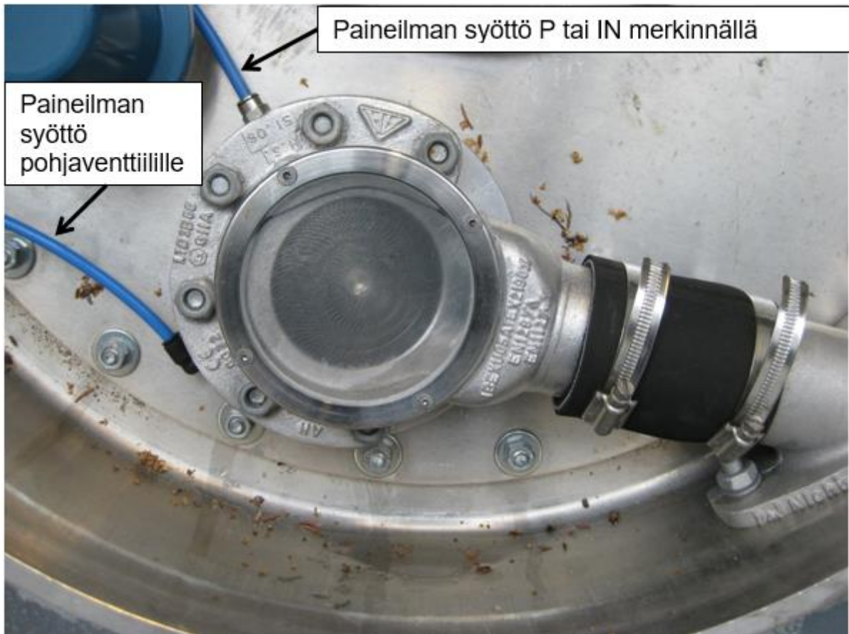
Kuva M6a 16. Liekkiloukullinen kaasunkeräysventtiili näkölasilla (venttiilejä on useita eri malleja).
